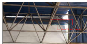
Foto 9 - Refazer trecho da calha a partir da emenda
