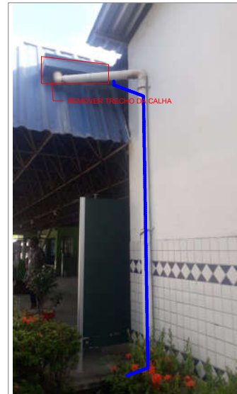
Foto 8 - Instalar tubulação
