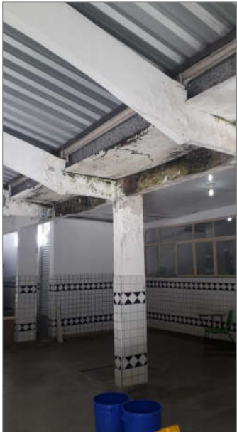
Foto 4 - Trecho ao longo de toda a calha para efetuar limpeza
